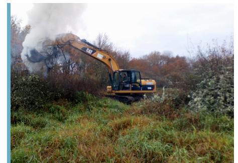
Travaux d'arrachage des saules
